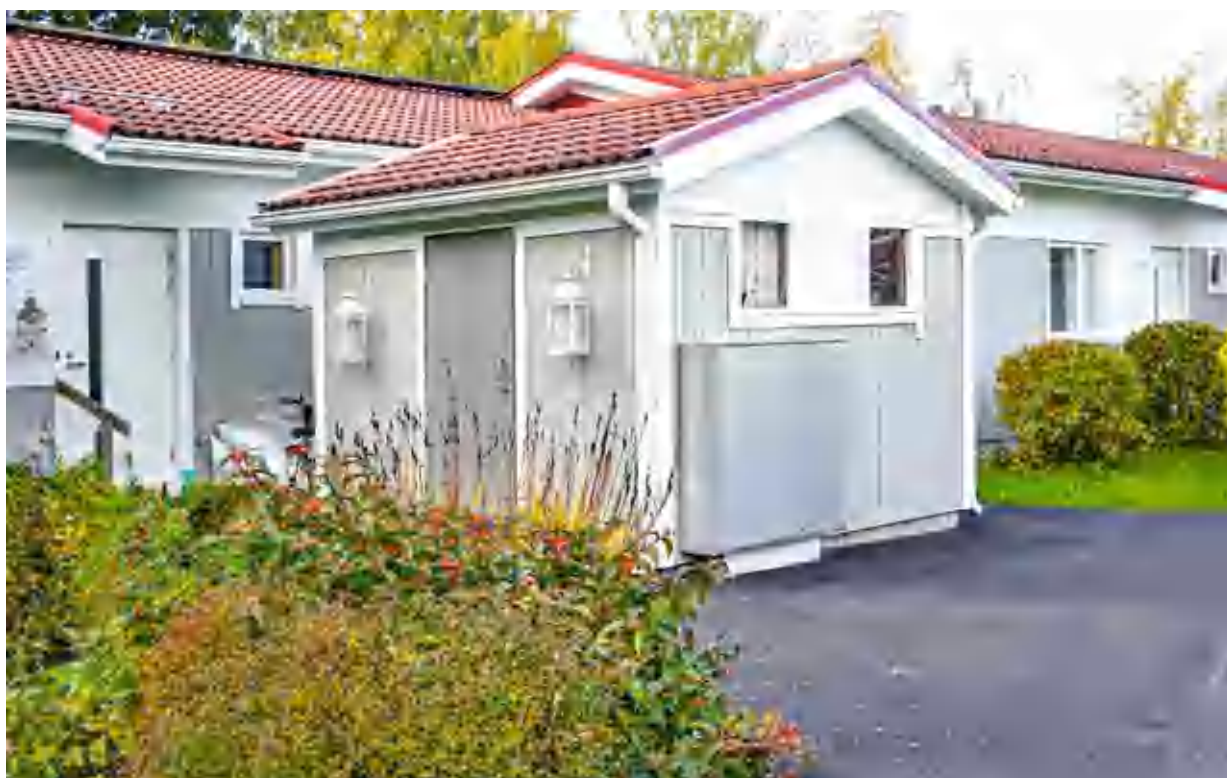
Perttelintie 20:n julkisivukorjaukset ovat kesän ja syksyn mittaan muuttaneet suuresti kiinteistön ulkonäköä.
