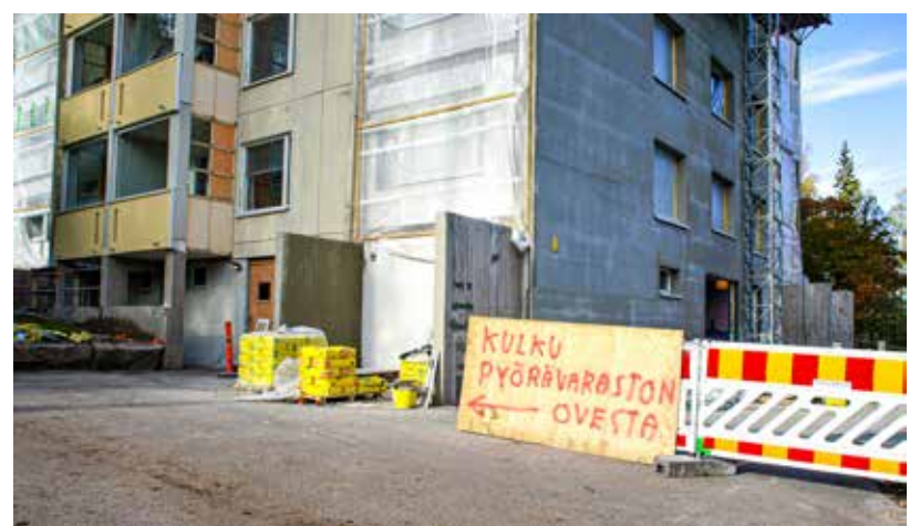
Iso korjaus on vaatinut ajoittain poikkeusjärjestelyjä sisäänkäynneissä.
